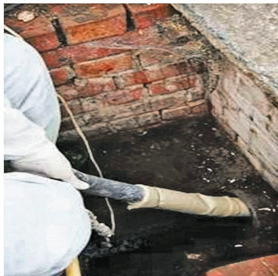
Рис. 7. Втягивание пакера в трубопровод
