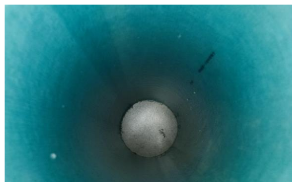
б) вид водостока изнутри
