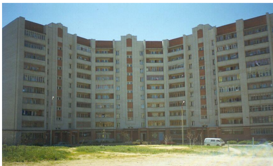
Рис. 1. Жилой многоквартирный дом (объект мониторинга)
