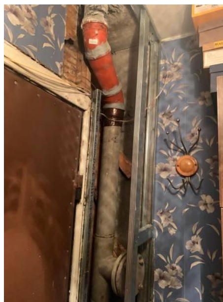
Рис. 1. Состояние внутренних водостоков МКД
