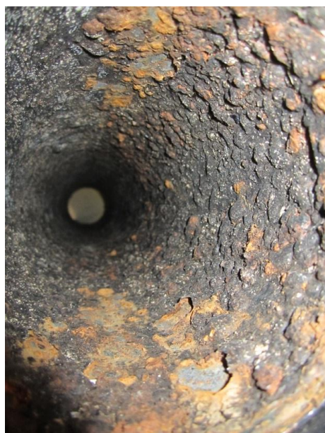
Рис. 1. Состояние внутренних водостоков МКД
