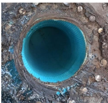
а) вид водостока с крыши
