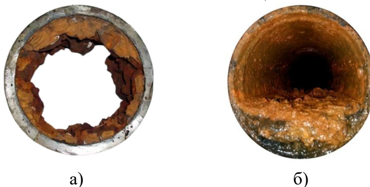
Рис. 1. Трубы водоснабжения – а), трубы водоотведения – б)
