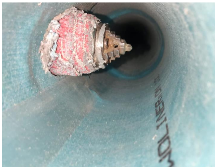
Рис. 9. Раскрытие примыканий
