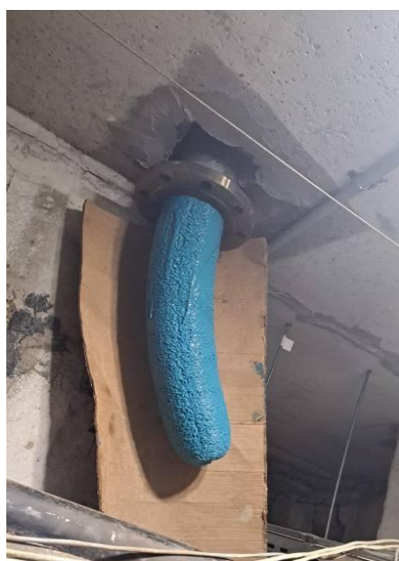
Рис. 8. Инверсированный рукав
