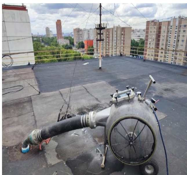
Рис. 7. Монтаж гибкого полимерного рукава с помощью инверсионного барабана
