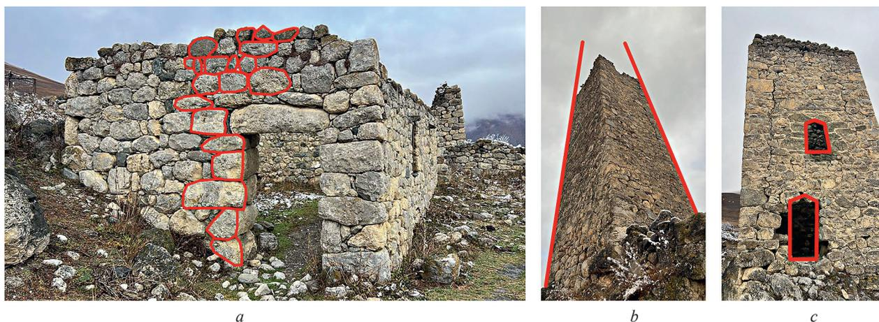
Рис. 2. Примеры вернакулярной застройки с. Цымыти: *a* — жилая постройка из камня, верхняя часть сложена насухо из более мелких камней; *b* — жилищно-оборонительный комплекс Бесаевых; *c* — жилая башня Дарчиевых (фотофиксация А. Токовой)
