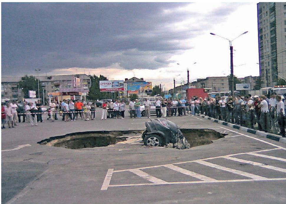
**Рис. 2.** Карстово-суффозионный провал на парковке ЦУМа в г. Дзержинске вследствие утечки воды при опрессовке магистральной теплотрассы (04 августа 2009 г.)<sup>9</sup>
