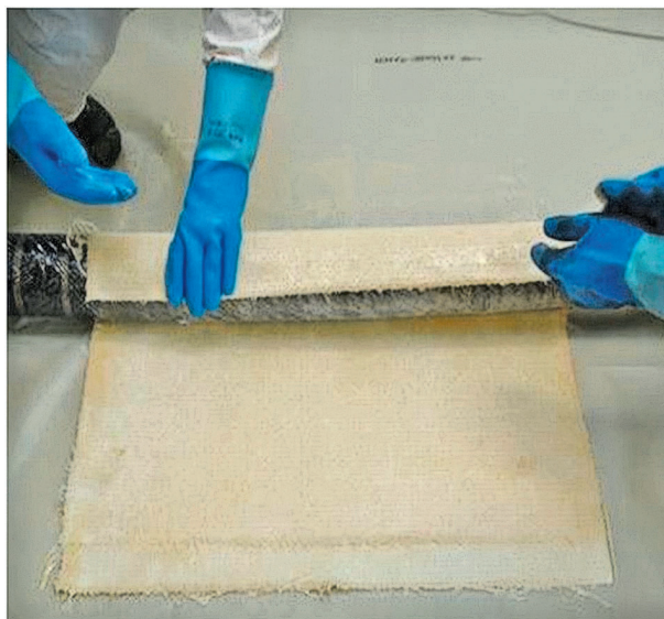
Рис. 6. Наматывание основы на пакер
